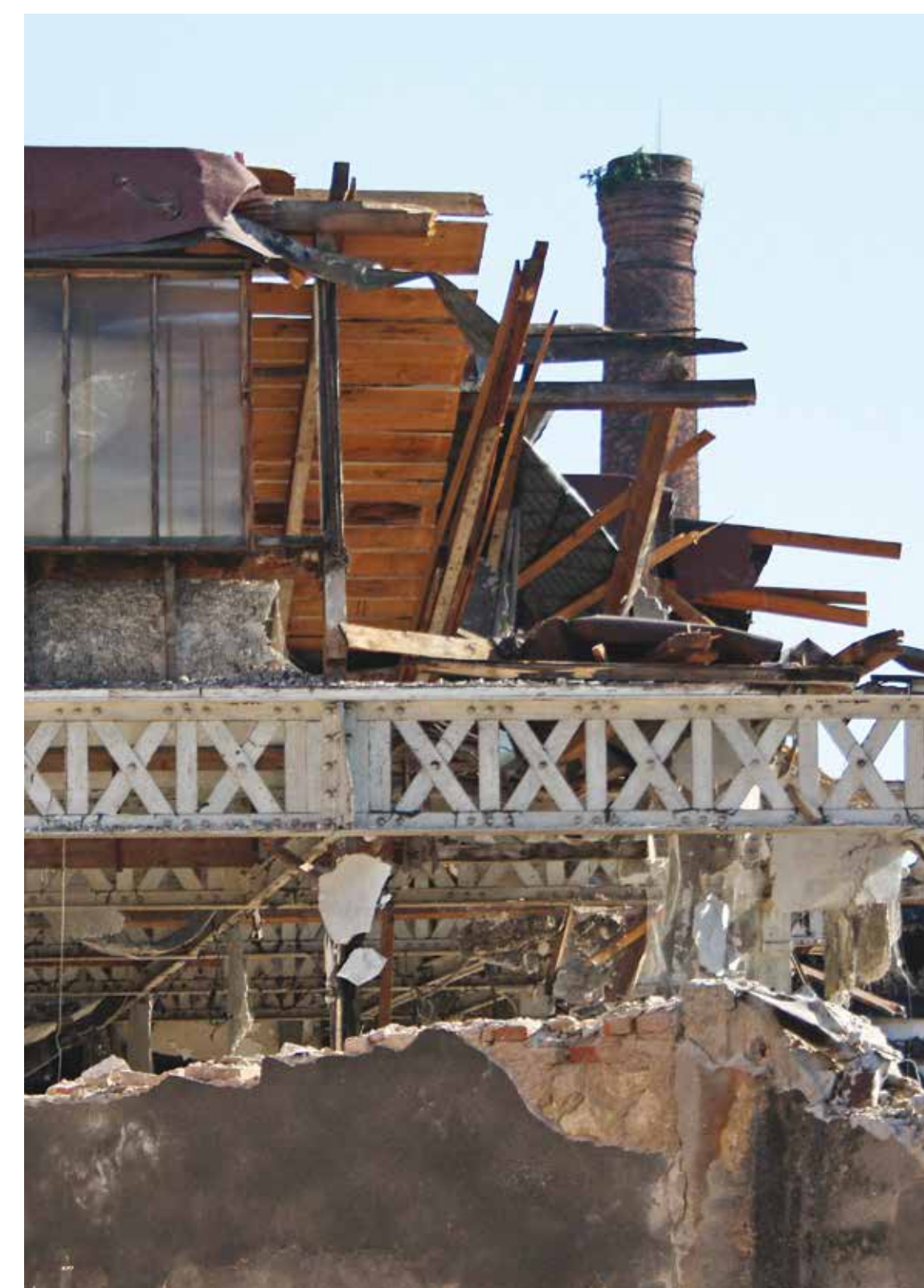
La demolizione del lanificio Tiberghien, particolare (foto di Michele De Mori).
